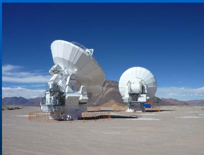
サイト (標高5200m、現在3台のアンテナが設置され試験中)
