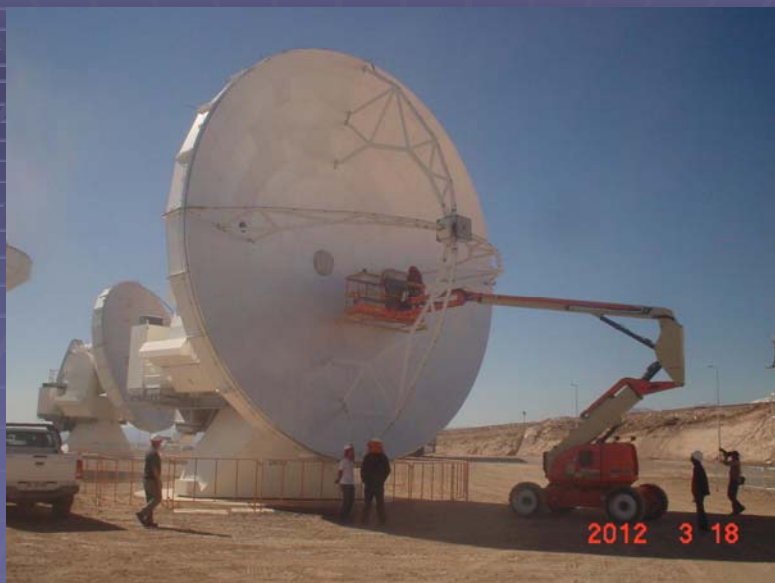
アンテナのパネル調整をしているところ
